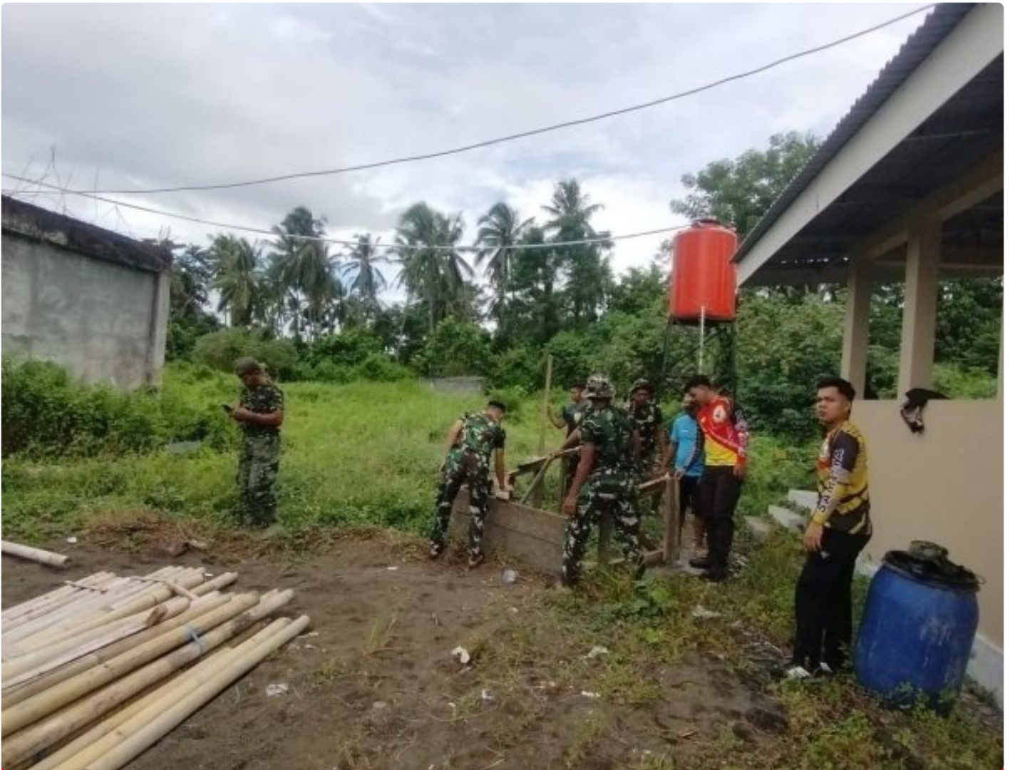
Satgas TMMD Ke-123 Kodim 1310 Bitung lakukan pekerjaan Rehab ruang kelas Panti Asuhan Hidayatullah Bitung
